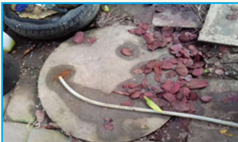
บ่อน้ำทิ้ง (น้ำย้อม+น้ำฟอก+น้ำล้าง) กลุ่มมัดหมี่โฮลโบราณ ตำบลเขวาสินรินทร์ อำเภอสวนรัตน บ่อซิเมนต์ ปล่อยให้ตกตะกอนและ ซึมลงดินด้วยวิธีธรรมชาติ
