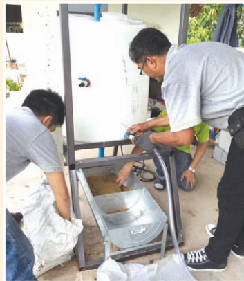
การติดตั้งระบบกรองตะกอน
