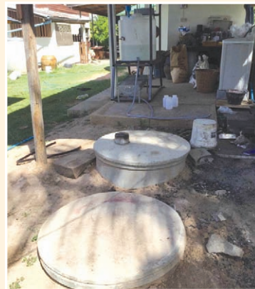
การต่อท่อน้ำเสีย หลังการบำบัดลงบ่อซึม
